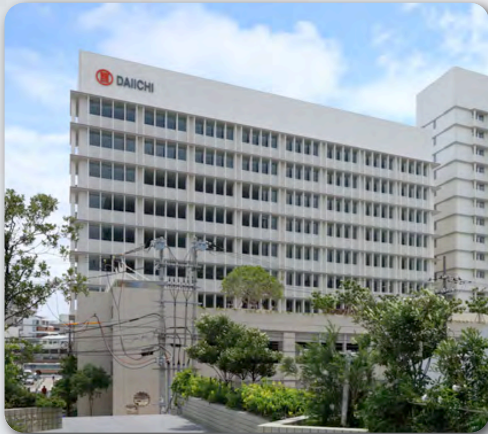
カフーナ旭橋 C街区 (那覇市)
